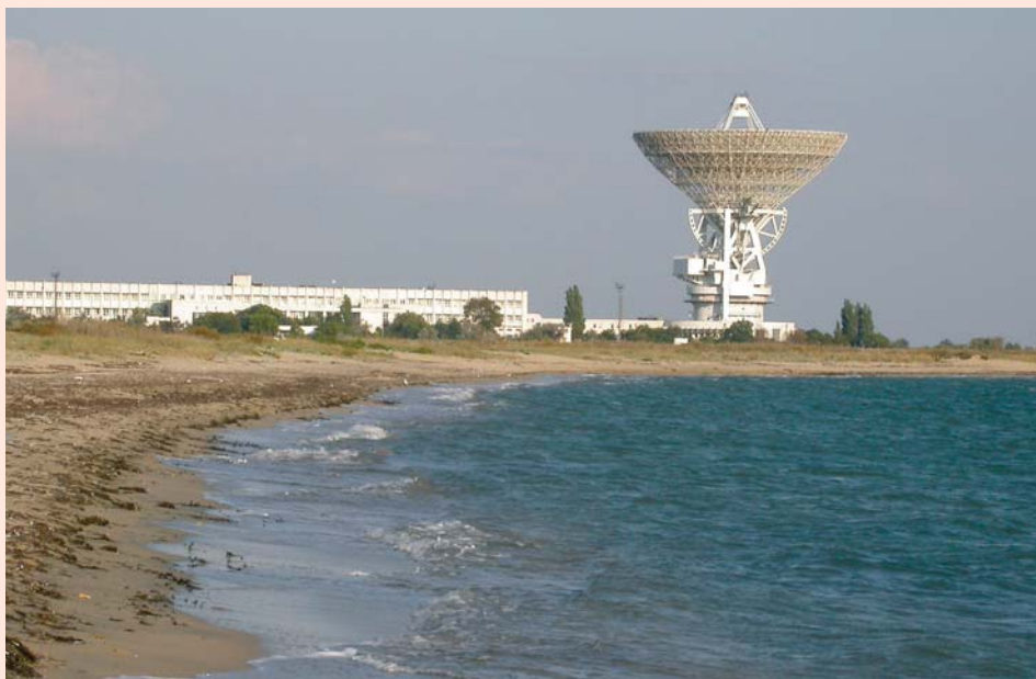
Радиотехнический комплекс "Квант-Д" с полноповоротной двухзеркальной антенной системой РТ-70 позволяет управлять космическими аппаратами в дальнем космосе
